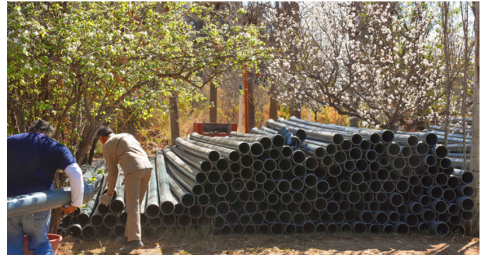
||||| Renovación del acueducto principal en la zona norte de Jáchal, Argentina
