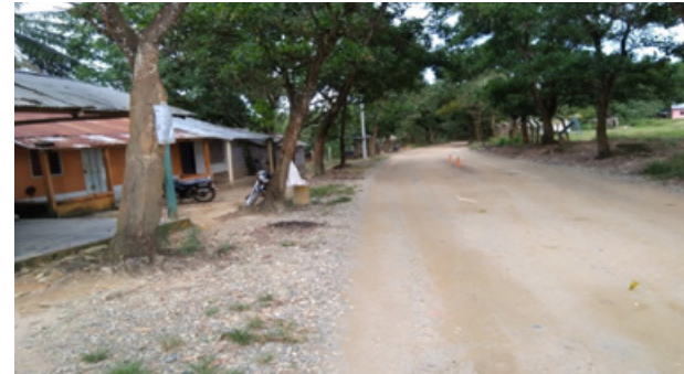
||| Vía Escarralao sin pavimentar, Colombia
