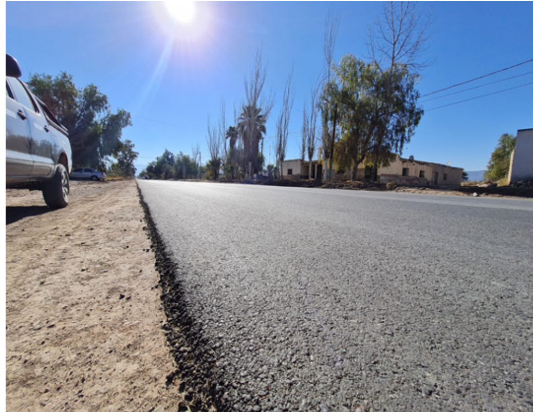
Pavimentación en calle Eugenio Flores. San José, Argentina
